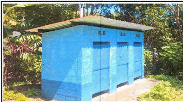
Foto 4: Segundo módulo de tres letrinas pintadas y entechadas con láminas troqueladas.
