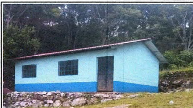
Foto 2: Aula de preprimaria entechada con láminas troqueladas, costaneras y tubos de 4 x 4, pintada.
