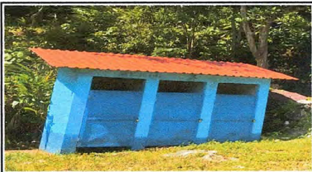
Foto 3: Primer módulo de tres letrinas pintadas y entechadas con láminas troqueladas.
